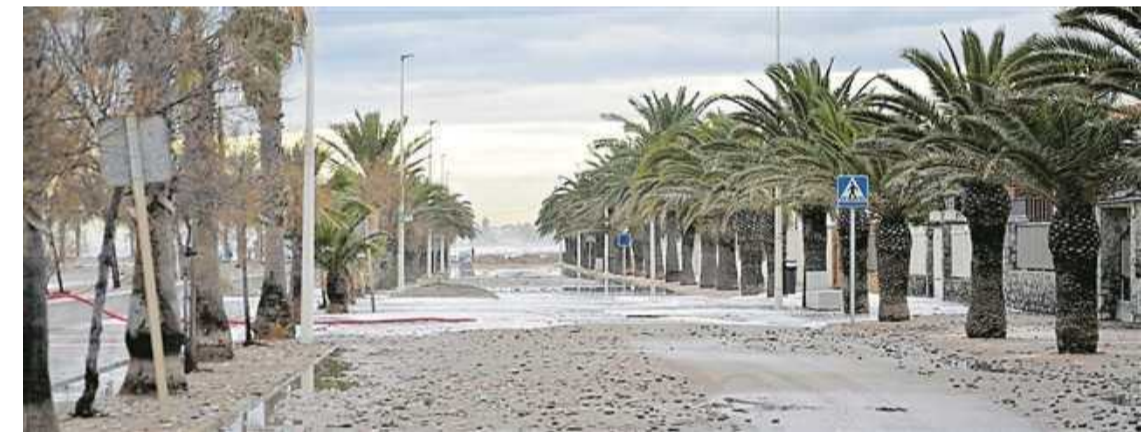
Estado en el que quedó la avenida Mare Nostrum tras el fuerte temporal que afectó al municipio.
