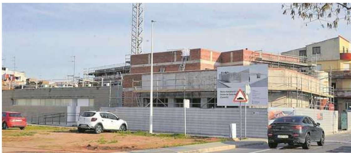
Actualment, s'este duent a terme l'ampliació del centre de salut que comptarà amb una planta superior.
