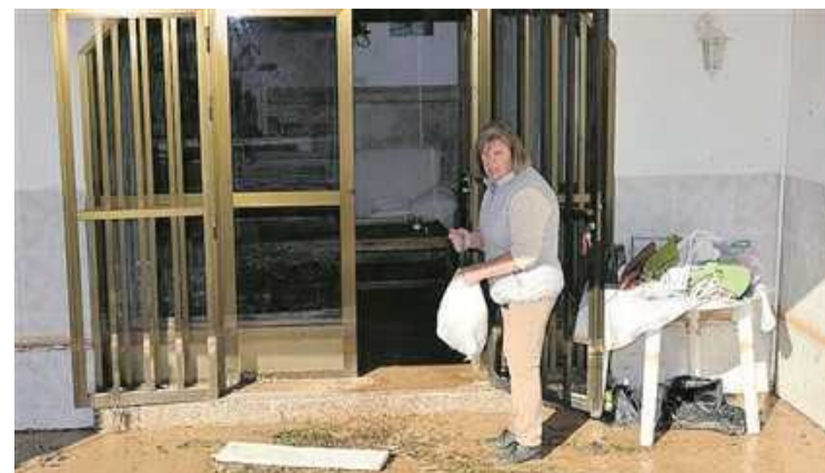
Desperfectos en una vivienda de la urbanización La Torre - Camí Cabres.
