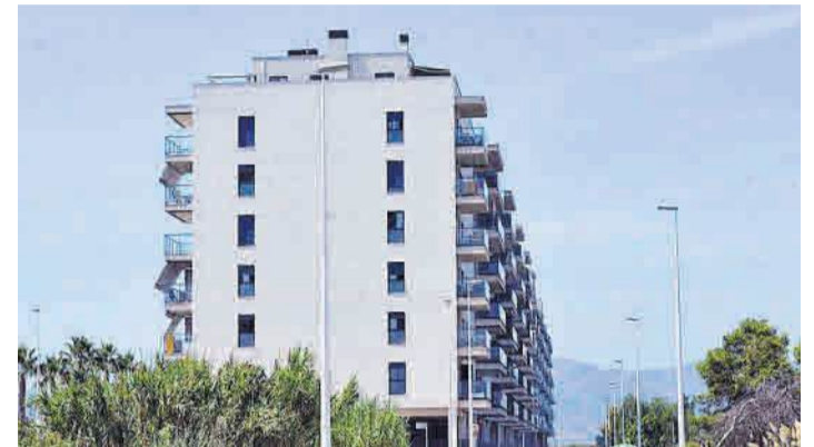
Las nuevas luminarias led completarán la totalidad del alumbrado público.
