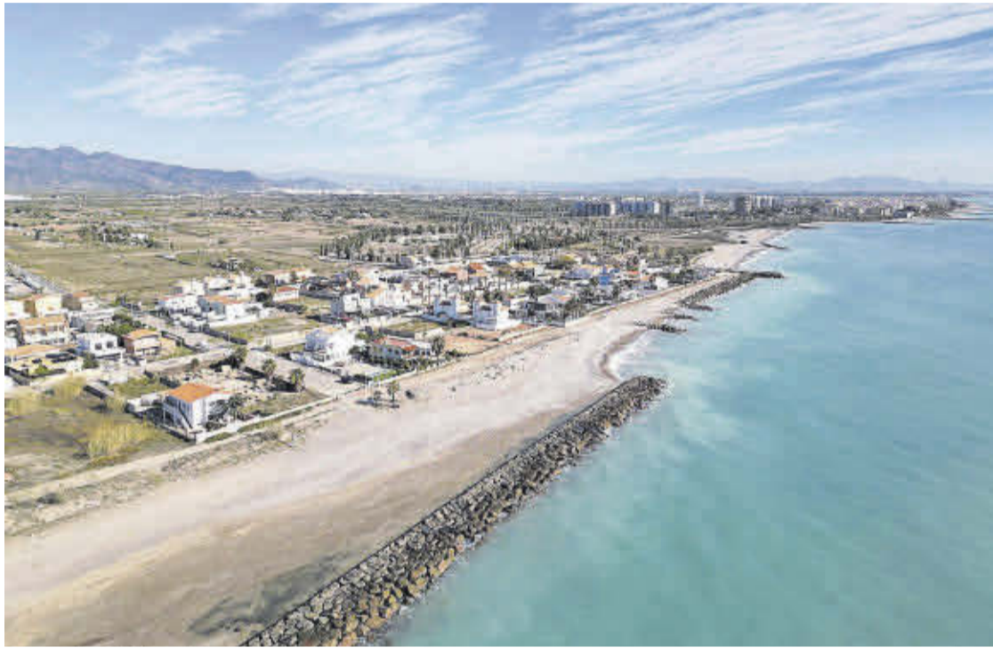
El tramo no cuenta con las defensas necesarias para salvaguardar las viviendas ni para hacer amplias zonas de baño.
