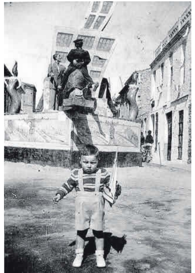
Falla del Camí la Vall.
