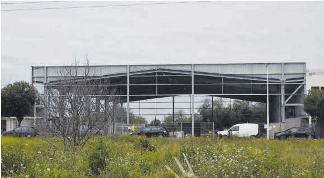
La carpa se está construyendo en el aparcamiento de vehículos que se encuentra entre el polifuncional y polideportivo.
