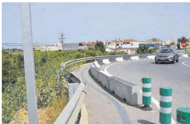
Paseo peatonal que se ha construido en paralelo a la circulación de vehículos.
