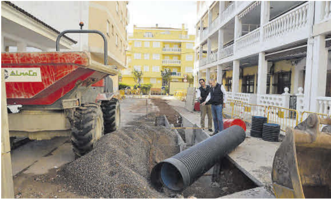
El alcalde Wences Alós y el primer teniente alcalde José María Andrés, comprobando los trabajos del nuevo conducto.
