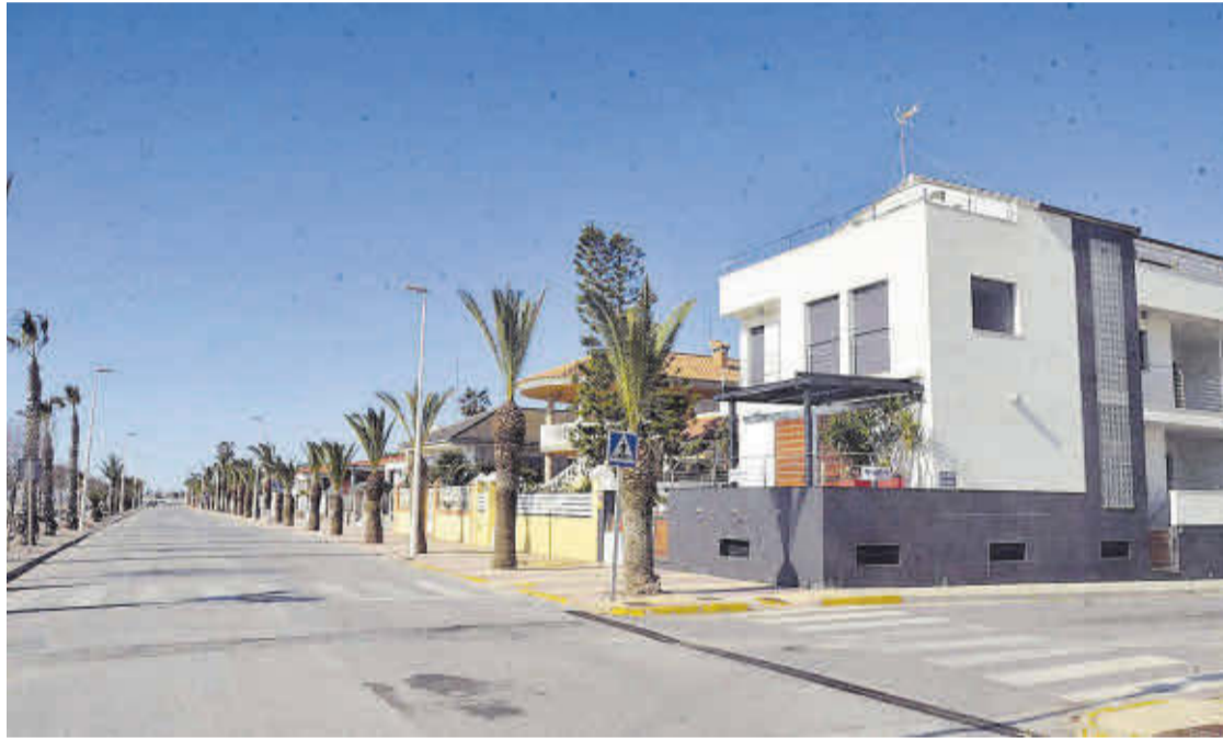
El tramo de la avenida Mare Nostrum que transcurre desde el Canal de Masbó hacia el sur será totalmente desmantelado.
