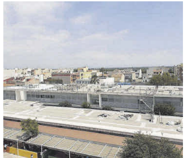
Vista de los trabajos que se han realizado en el forjado de todo el colegio.
