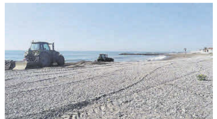
La maquinaria pesada trabaja a lo largo de los seis kilómetros de litoral.
