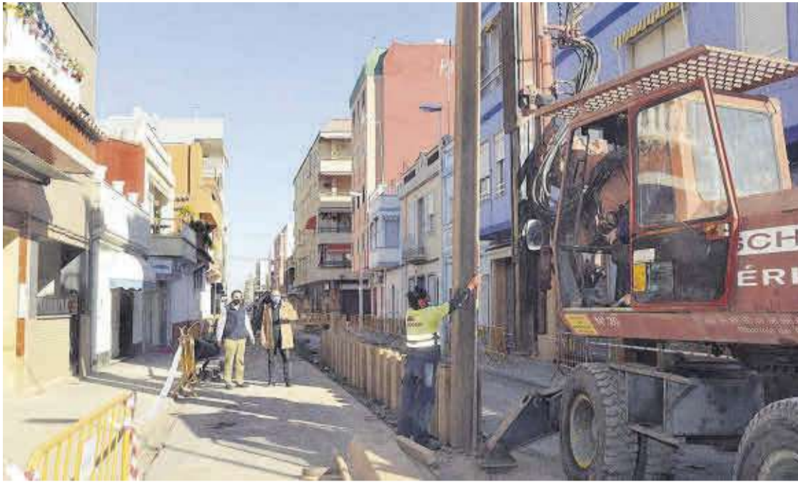
El alcalde de Moncofa, Wences Alós, y el primer teniente alcalde, José María Andrés, comprobando el avance de las obras.
