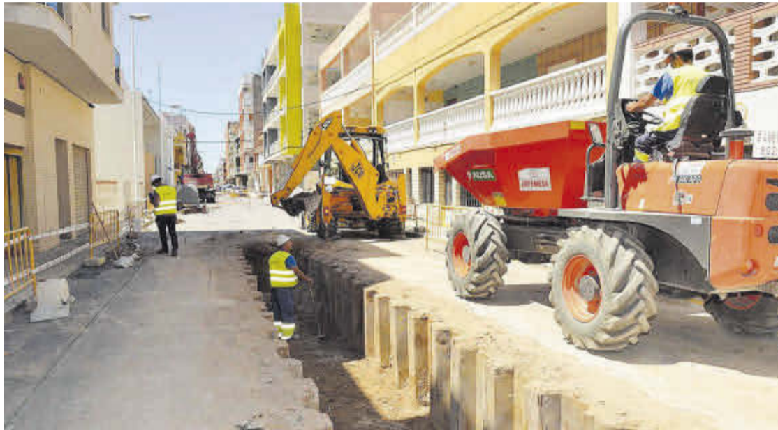
Los trabajos del cambio del colector de aguas residuales se reiniciarán en la calle Almirante Cervera, sita en la playa.
