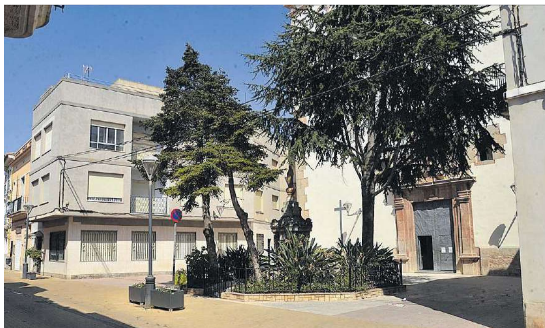
L'Ajuntament i el taller d'ocupació portaran a terme la rehabilitación integral de la font de la plaça de l'Església.
