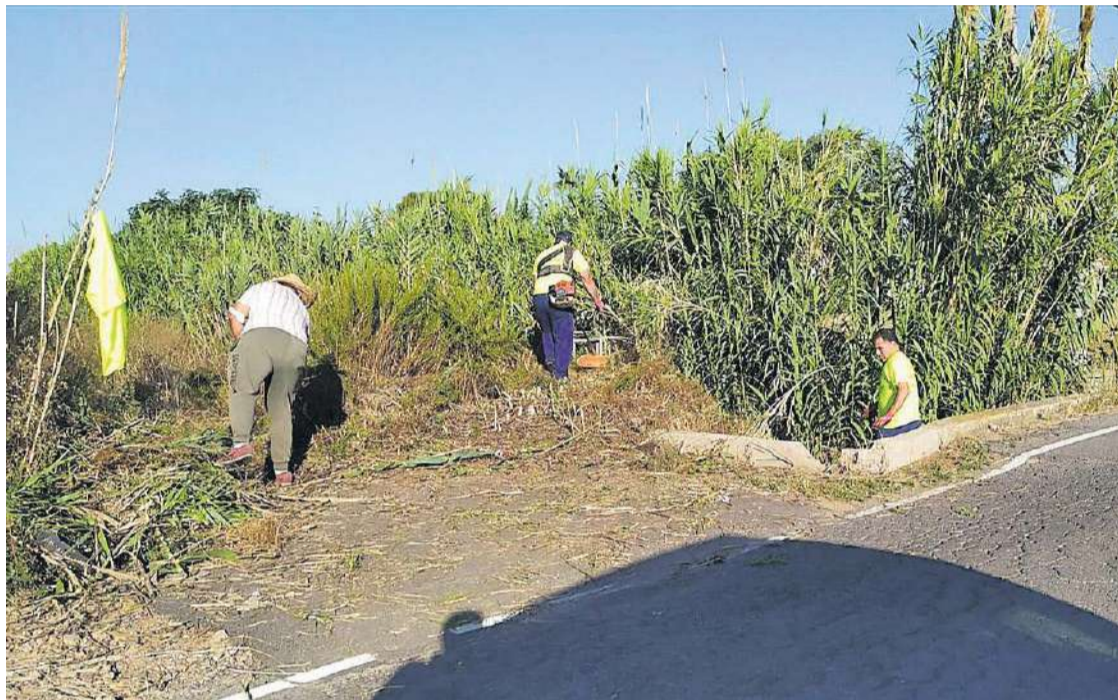
Los trabajos del paro agrario se están centrando en la limpieza de acequias y márgenes de caminos de la zona agrícola.
