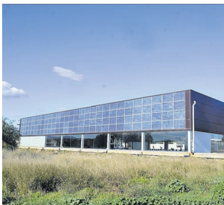
Lateral del polideportivo municipal donde se encuentran las placas solares.
