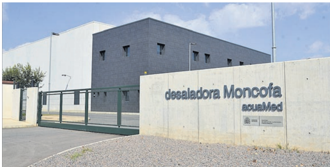
En la actualidad, la planta desaladora únicamente destina agua desalada a la conducción de Moncofa.
