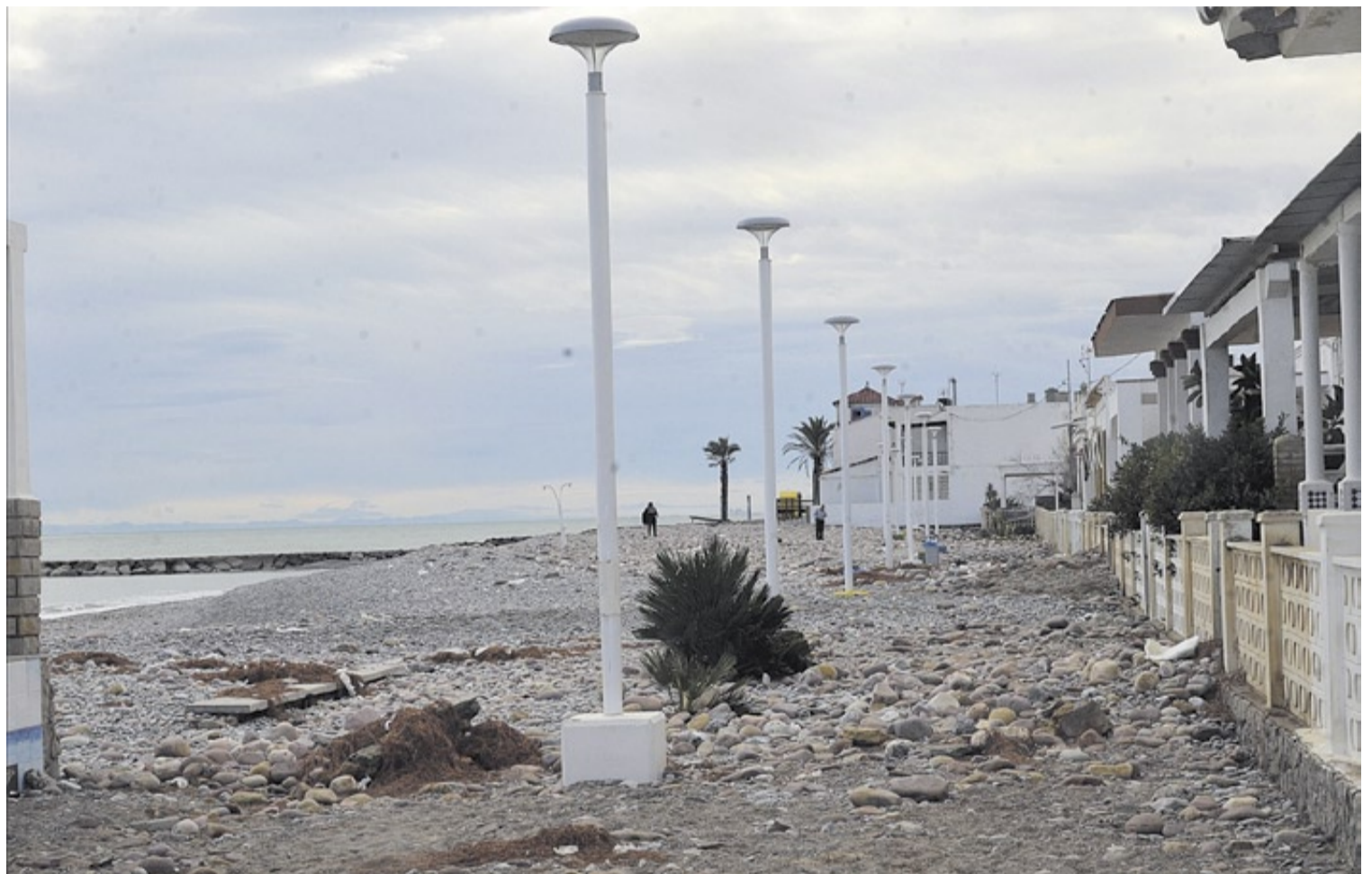
El paseo marítimo ha acumulado grandes cantidades de piedras y arena arrastradas por el intenso oleaje, cuya fuerza ha provocado daños en varios tramos.
